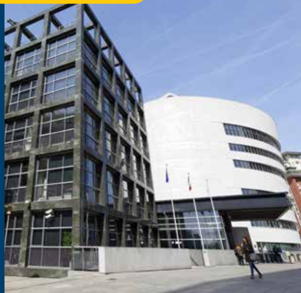
CAMPUS DU PÔLE (1995)
